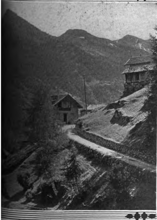
ent road en route to Finhaut
